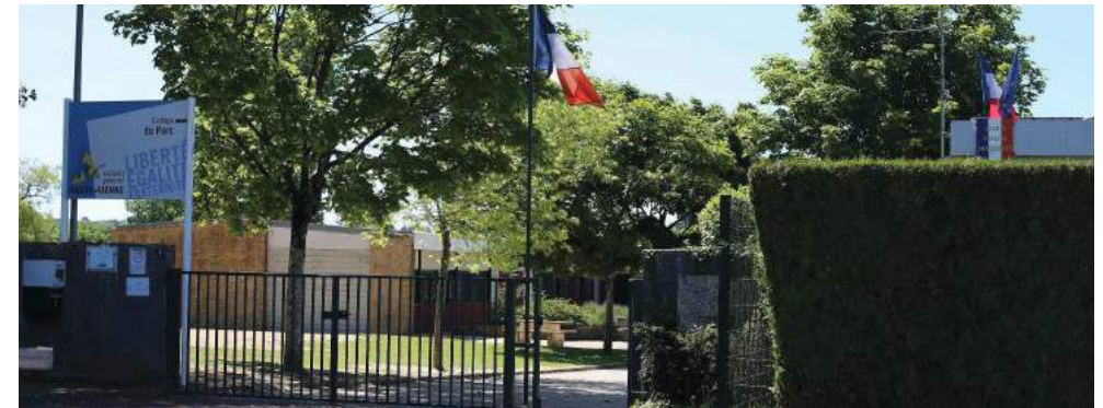
Photo 32 : Collège du Parc à Saint-Mathieu
